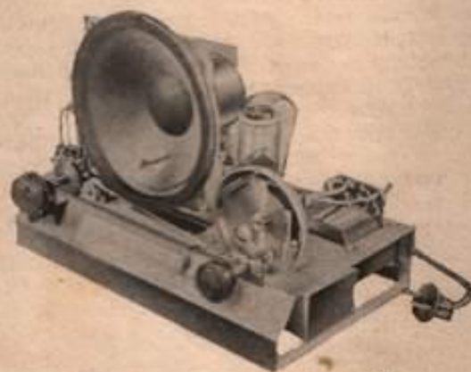
Abb. 5. Waagrechtter Skalenantrieb.
